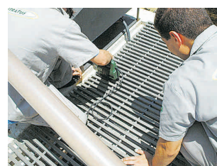
Instalação de grade de piso
